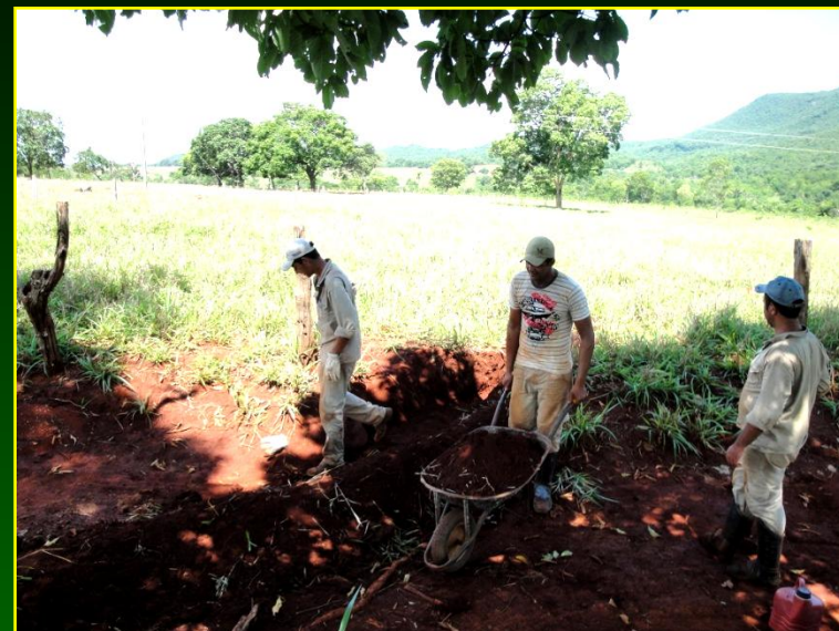
CONTROLE DE EROSÃO
