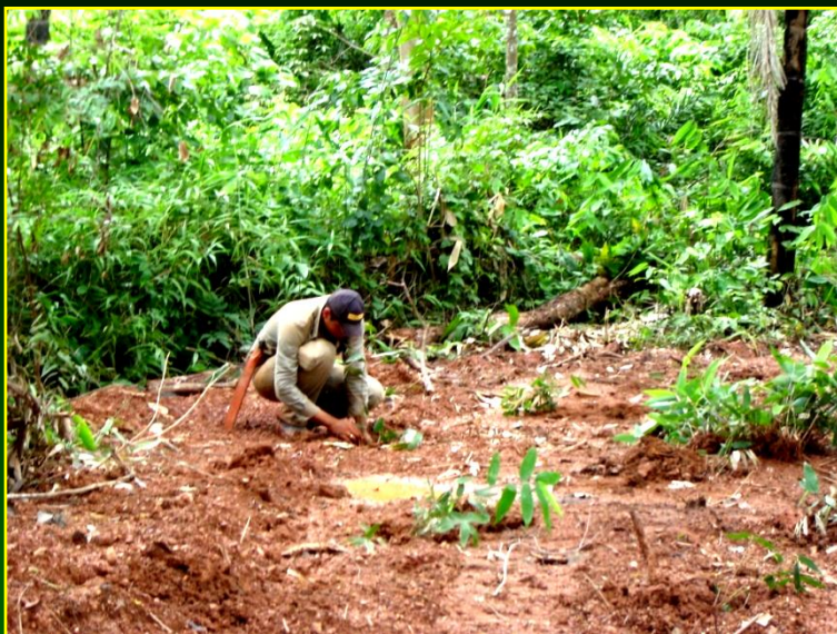
RECUPERAÇÃO DE PRAÇAS DE SONDAGEM
